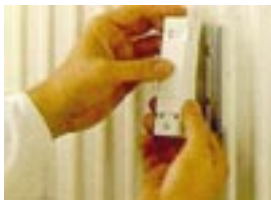
Τοποθέτηση θερμοδομετρητών στο σώμα του καλοριφέρ υπάρχουσας εγκατάστασης.
